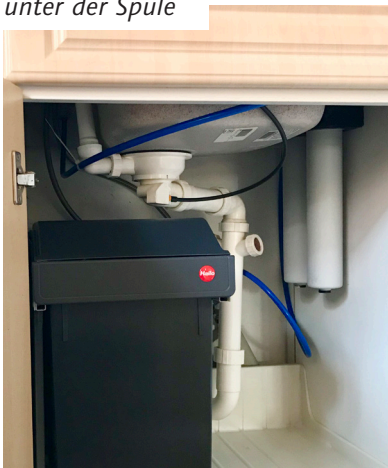
FINO-QC als Einzel-, Doppel-, oder Dreifachgehäuse, seriell oder parallel
